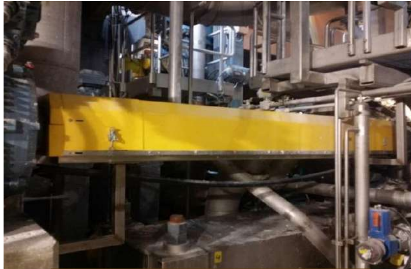
Kuivausryhmän pitkän lamellikytkimen suojakotelo
